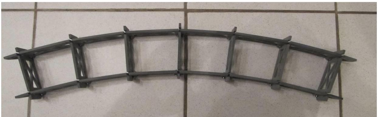
Bild 4 (Längs und Querträger zusammengesteckt)
